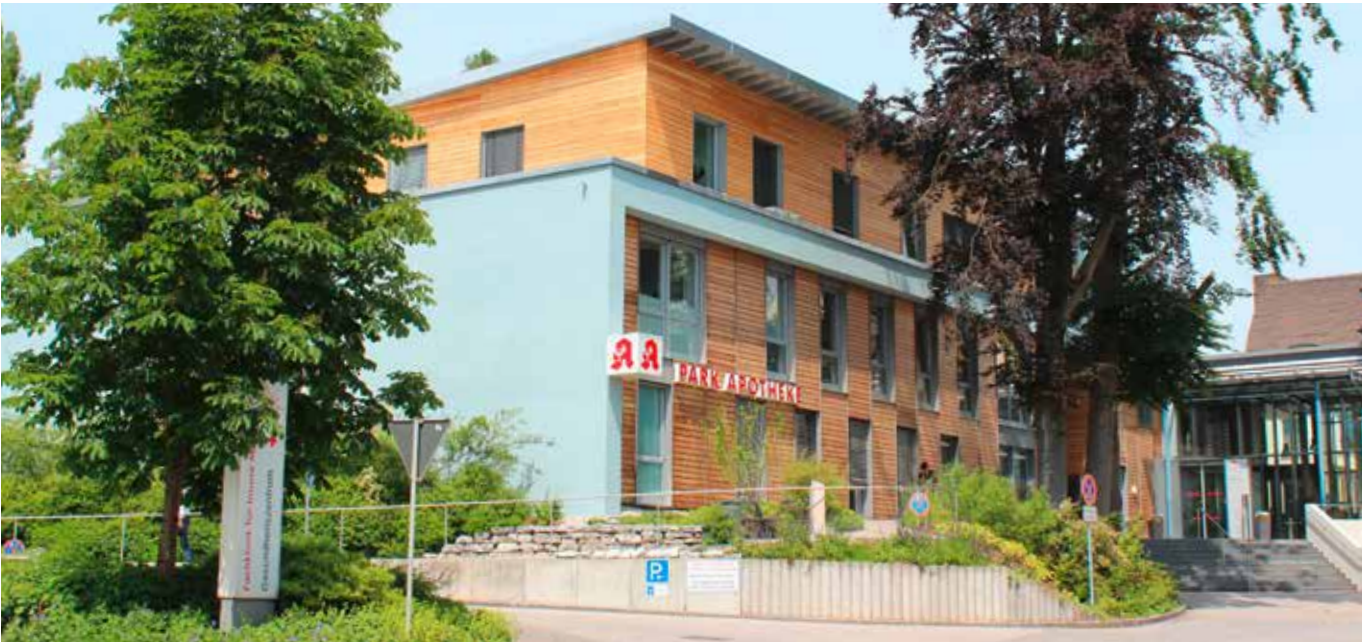
Das Ärztehaus in Dorfen wurde um ein Stockwerk aufgestockt.
